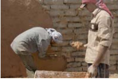
Operai che lavorano al restauro del Palazzo Reale di Mishrifeh/Qatna, Siria (XVI-XIV secolo a.C.). Scavo dell'Università di Udine. (Foto Javier Ballester Serrano)
